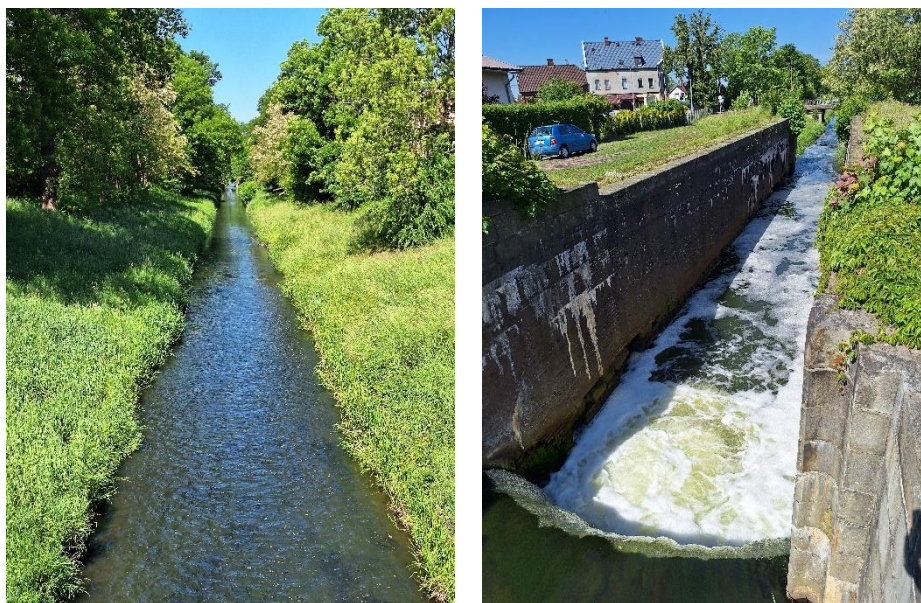
Ryc. 13. Kanał Kłodnicki: widok z mostu na ul. Pocztowej w kierunku Odry), śluza nr 2
